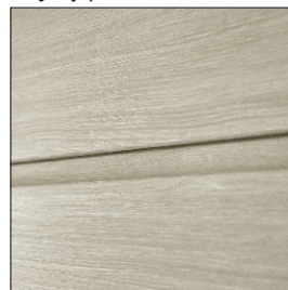
Łączenie między panelami
