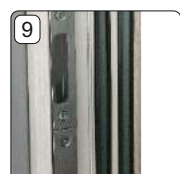
Przegroda termiczna, dwie uszczelki w ościeżnicy
