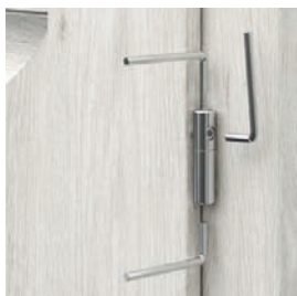
regulacja zawiasów czopowych regulowanych 3D
