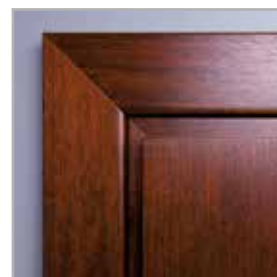
łączenie opasek pod kątem 45°
