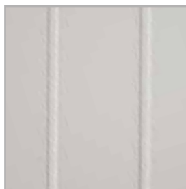
frezowanie na powierzchni skrzydła
